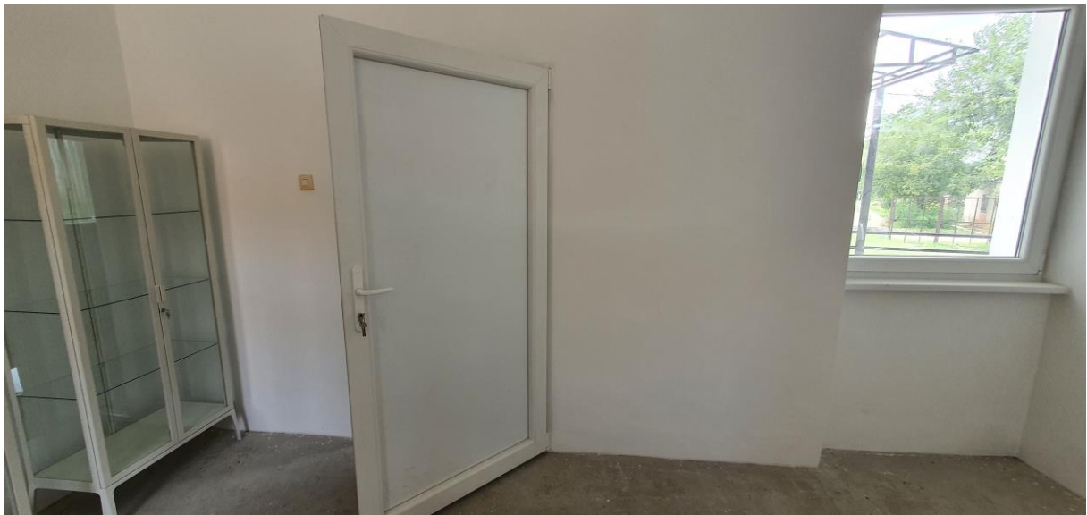
Belső műanyag ajtó a mozgássérültek könnyebb közlekedése miatt 110cm szélességben
