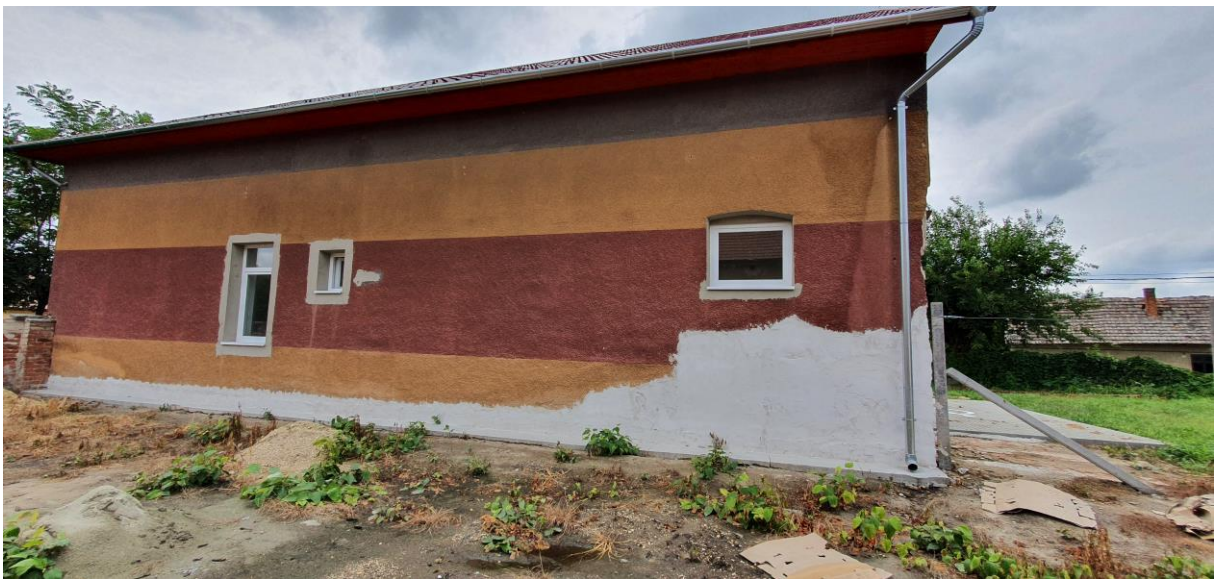
A hátsó külső homlokzat, melyen szintén láthatók nyílászárók, valamint a falszigetelés nyomai
