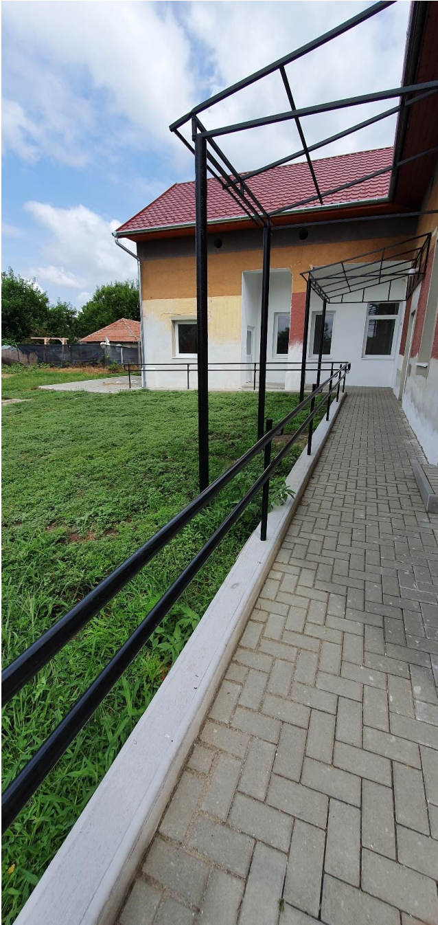
A mozgássérült feljáró, a korláttal, a falszigeteléssel és az udvari nyílászárókkal
